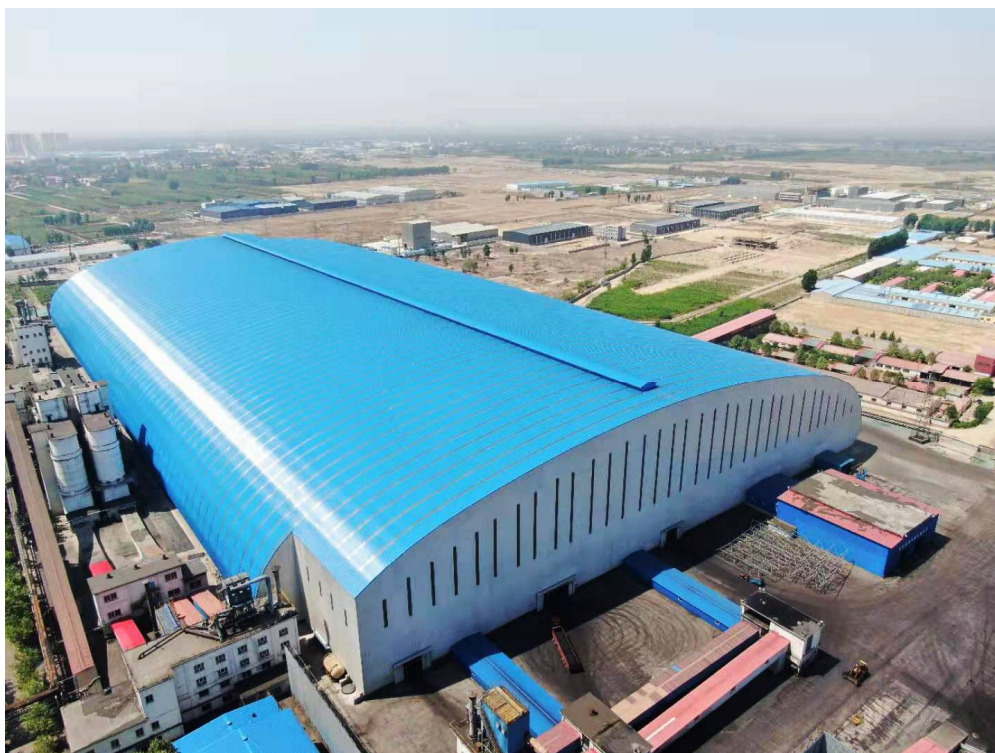
河北旭阳焦化有限公司南煤场全封闭项目工程
